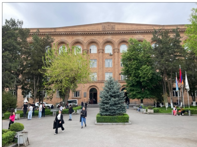
Façade sur rue de l'école polytechnique qui s'étend sur plusieurs hectares dans la ville d'Erevan
