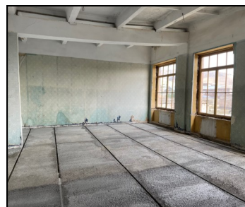
La même salle avant rénovation
